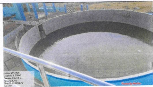
Pic.8: Effluent Sump
